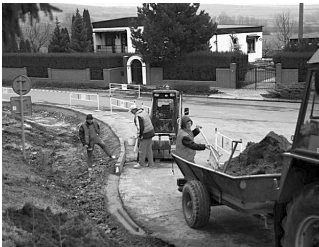
Oprava křižovatky ulic v Údolí a Pod Břehy.
