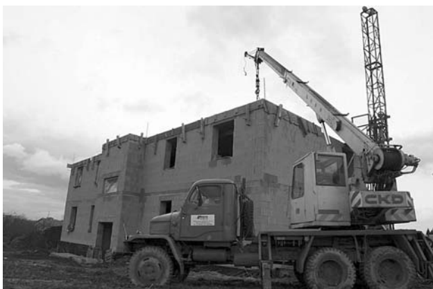
Bytovky budou brzy pod střechou ...
