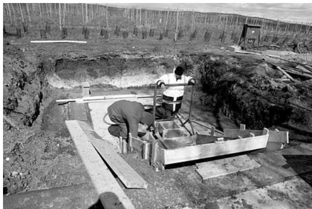
Návštěvníci rozhledny nemusí mít v žádném případě obavy – základy rozhledny (na snímku jejich budování) jsou pevné a bytlivé. Vítr tedy nás ani rozhlednu neodnese :-)! Foto: Ing. Zdeněk Karber
